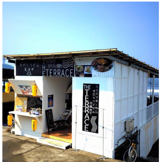
海の家「The Terrace」＝片瀬海岸（神奈川県）
